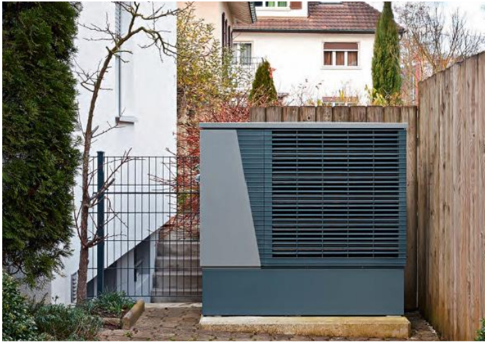
Bild: Aussen aufgestellte Luft/Wasser-Wärmepumpe
