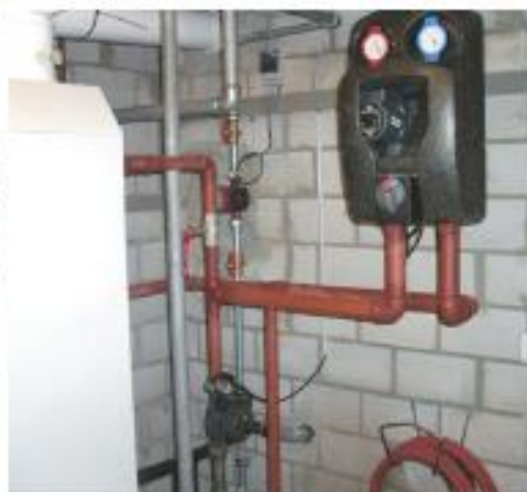
Links Thermische Solaranlage 25 m 2 . Einsparung durch Weglassen Dämmung CHF 1400.–. Geringere Solarernte in 25 Jahren CHF 1900.–. Mitte Neubau: Erdgastherme mit Boiler. Einsparung durch Weglassen Dämmung CHF 300.–. Mehrverbrauch in 25 Jahren CHF 600.–. Rechts Altbau: Ölkessel mit Boiler. Einsparung durch Weglassen Dämmung CHF 200.–. Mehrverbrauch in 25 Jahren CHF 700.–.
